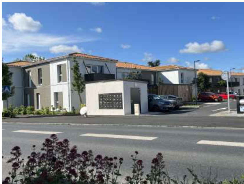
Photo 7. Illustration d'un immeuble collectif intégré dans le tissu urbain : la résidence intergénérationnelle
